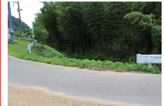
1-4. ガードレールがない箇所があり危険
