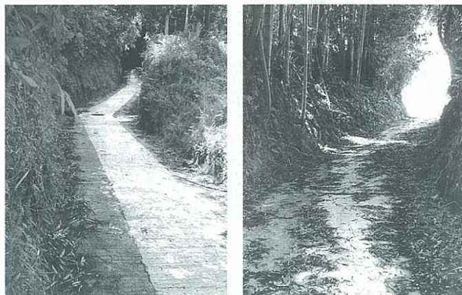
上長田の人が住んでいない所への配管工事(約200m)
