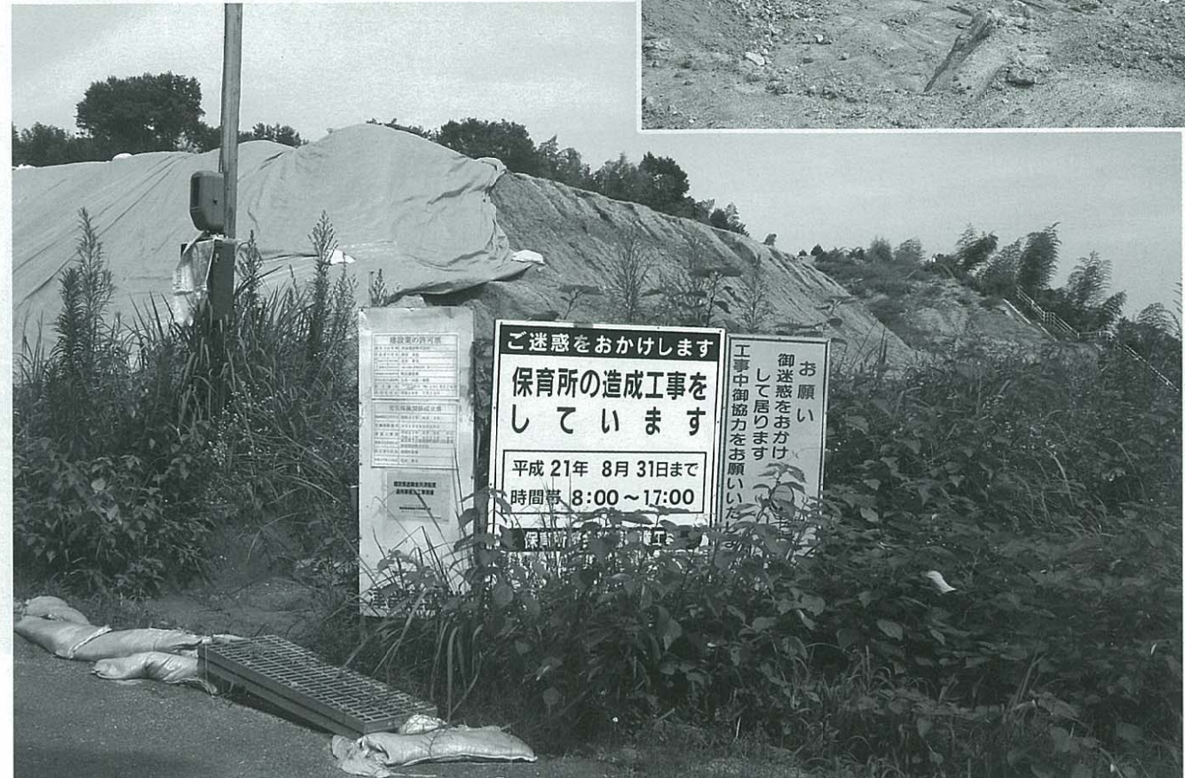
造成工事の様子。 看板では8月31日までとなっている。
