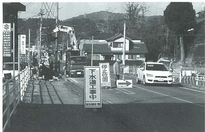
関町の下水道工事の様子
