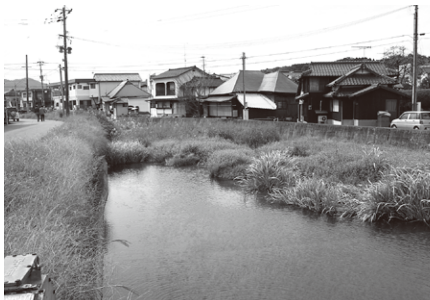
土砂の堆積状況
