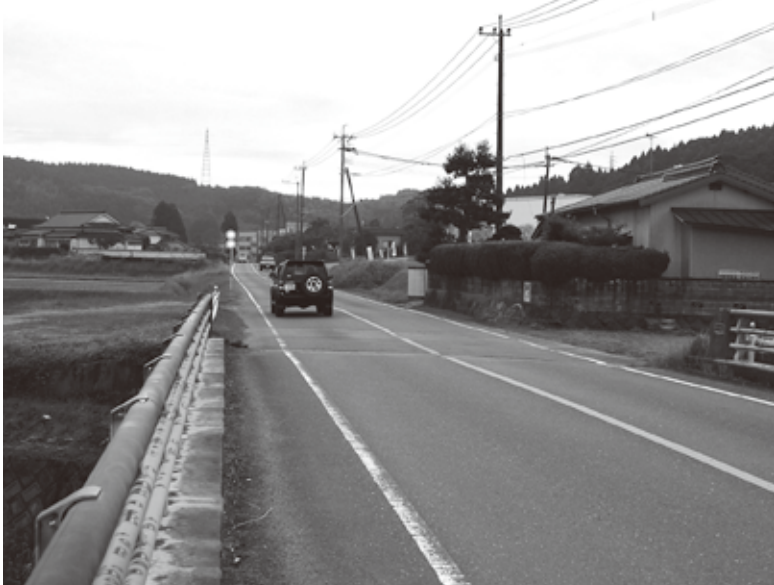
県道大牟田～植木線（下坂下北の辺田橋付近）
