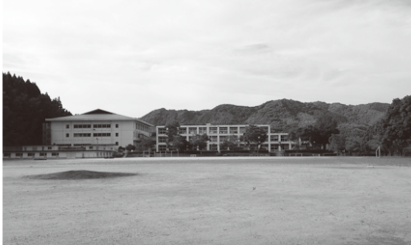
エアコン設置予定の南関中学校
