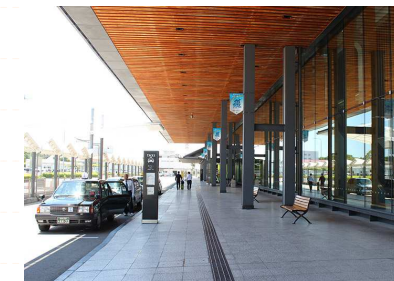
雨に濡れない車寄せの例
