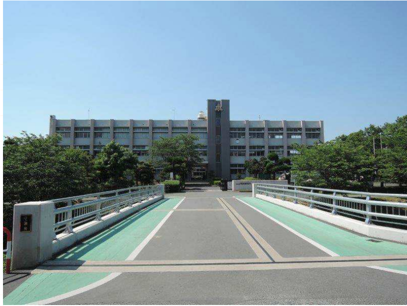
A 正門から管理棟を見る
