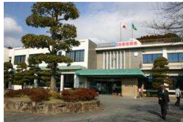
耐用年数が過ぎ耐震性の課題が残る既存庁舎
