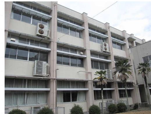
旧教室棟 室外機（改修時撤去後の外壁補修有り）
