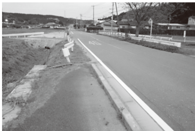
県道大牟田・植木線、北の辺田橋付近
