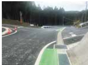
1. 町道米田 ～大場線改良工事
