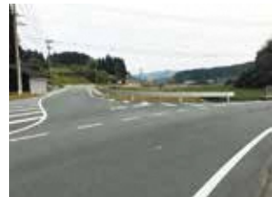
4. 町道野中 ～出登線改良工事
