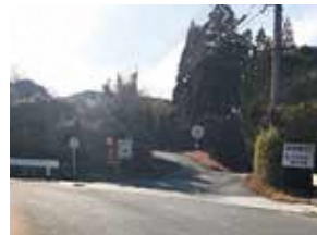
3. 町道鬼王 ～大場線改良工事
