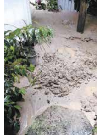
宮尾民家への土砂災害
