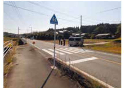
田原地区歩道
