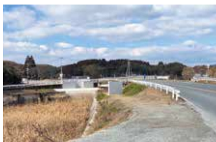
野中橋の側道橋
