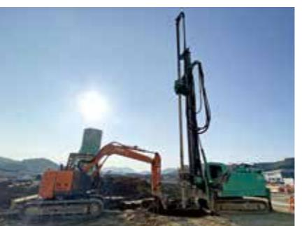
木造2階建ての増築棟建設のため、地盤改良杭(174本)を打ち込む工事を行いました。
