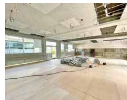
▲1枚目の写真是、改修棟(教室内装工事の写真です。以前は美術室として利用されていました。)が、展示棚流し台が撤去され、OAフロア化のため床工事がなされています。
