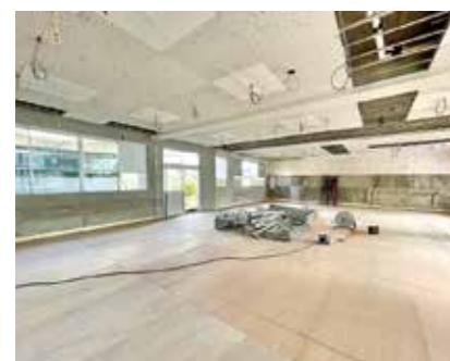
▲1枚目の写真是、改修棟(教室内装工事の写真です。以前は美術室として利用されていました。O Aフロア化のため床工事がなされています。)
