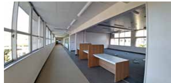
▲執務室(改修棟2階)
