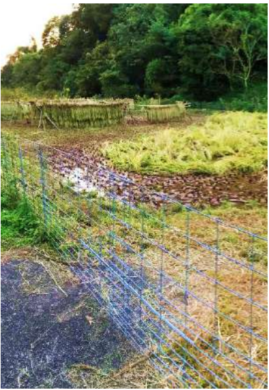
溶接されたパネル状の柵を並べて張る
