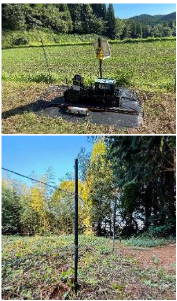
電源を設置し、電気を通す柵線を張る
