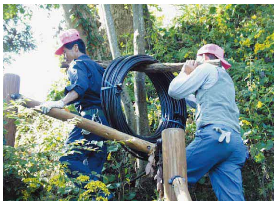
「電飾設置作業」
